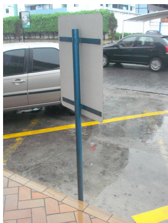
Foto 09 – Modelo da barra chata para sustentação da placa.
